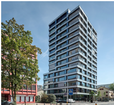
Schweiz. Obstverband Zug, 6300 Zug Hochhaus 50m Wohn-Bürofläche, 16 Geschosse HLKS - Anlagen
