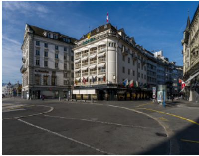
Bucherer Schwanenplatz, 6002 Luzern Um-Ausbau Gesamtanlage HLKS + MSR - Anlagen
