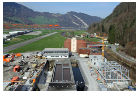
ARA Sarneraatal, 6055 Alpnach Ausbau Gesamtanlage HLK + prozesslufttechnische Anlagen
