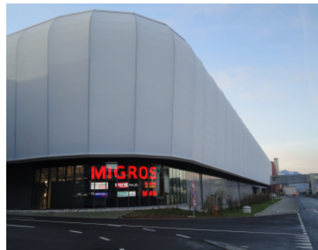
Mall of Switzerland, 6030 Ebikon Mieterausbau für Migros HLKS + MSR - Anlagen
