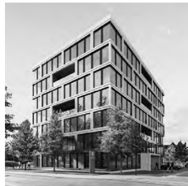
Bürohaus Alpha, 6340 Baar Neubau Geschäftshaus mit ca. 4700 m 2 Bürofläche. Planung HLS Anlagen + Fachkoordination für den Grundausbau und div. Mieterausbauten
