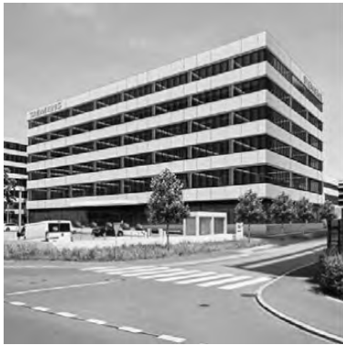
Siemens TH1c, 6300 Zug Gebäude-Gesamtsanierung inkl. den kompletten HLKS-Anlagen in der BIM Methode für ca. 20 000 m 2 Büro- und Labornutzung
