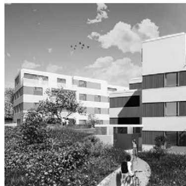
3 MFH Bifang, Hausen am Albis Neubau von 3 MFH mit Anbindung an den Fernwärmeverbund der Albisbrun- Stiftung Planung von HLS Anlagen + Fachkoordination
