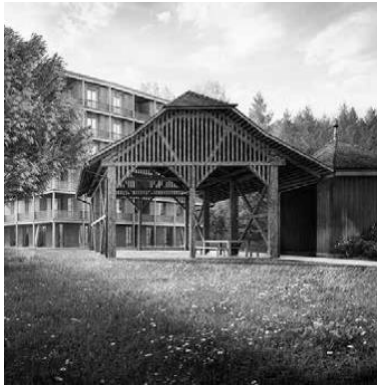
MFH Francesco, Kloster Wesemlin, Luzern Neubau mit 30 Wohnungen, Dienstleistungs- und Praxisräume im Erdgeschoss Planung von HLS Anlagen + Fachkoordination
